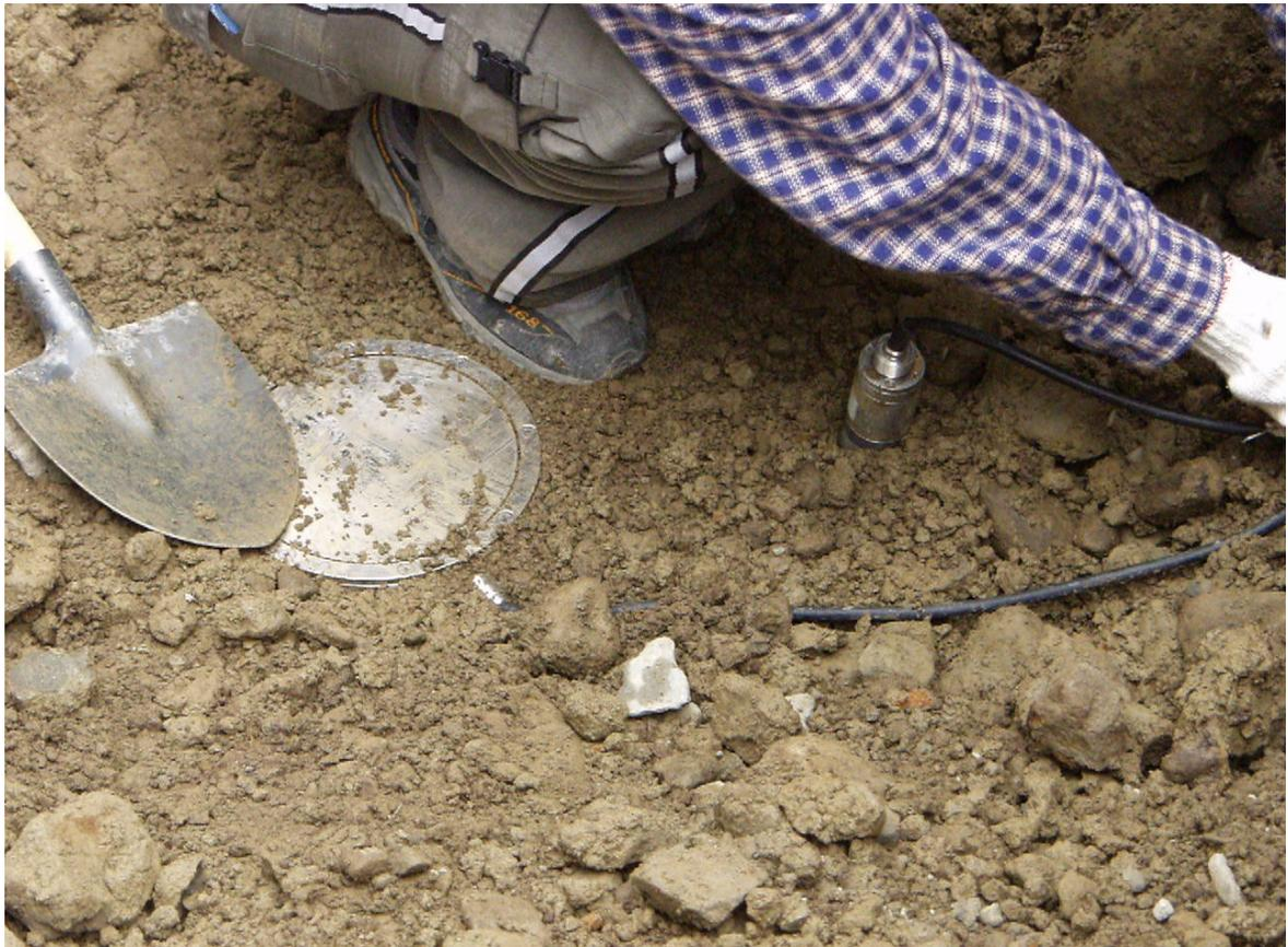
圖 5-6 水壓力計與土壓力計
