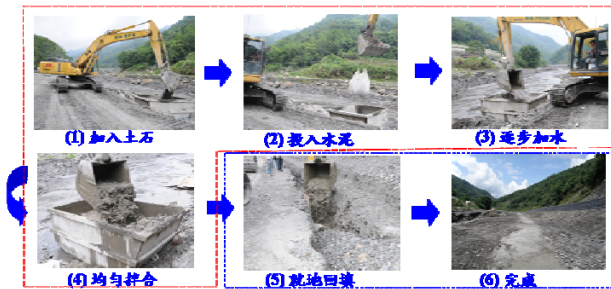
圖 26 「現地拌合法」施工流程
