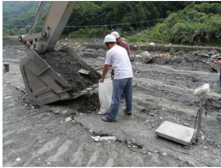
圖 25 挖土機挖斗盛裝土石秤重試驗
