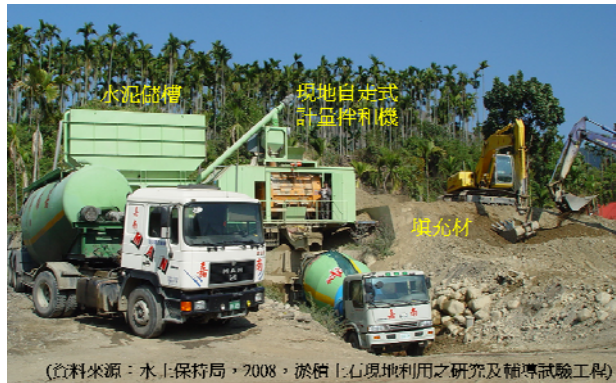
圖 3 淤積土石混凝土現場機具佈置
