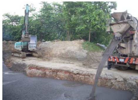
圖 2 地下管溝回填 CLSM
