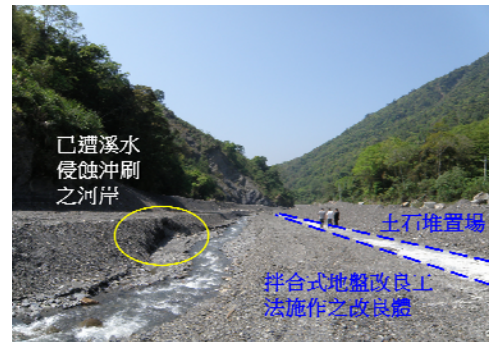
圖 24 拌合式地盤改良工法之改良體與對岸已遭溪水侵蝕冲刷之河岸
