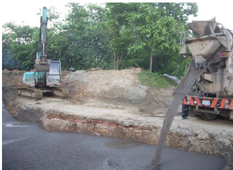
圖 2 地下管溝回填 CLSM
