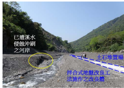
圖 4 拌合式地盤改良工法之改良體與對岸已遭溪水侵蝕冲刷之河岸
