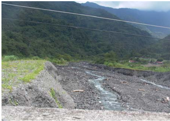
圖 23 土石流堆積的治理工程
