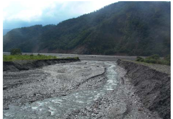
圖 24 土石流堆積再刷深
