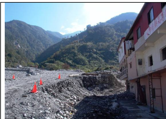
圖 53 松鶴部落的土石流災害
