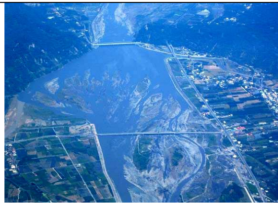
圖 46 集集攔河堰造成的淤砂
