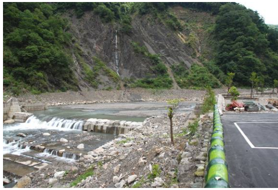
圖 42 苗栗汶水溪的河道治理工程
