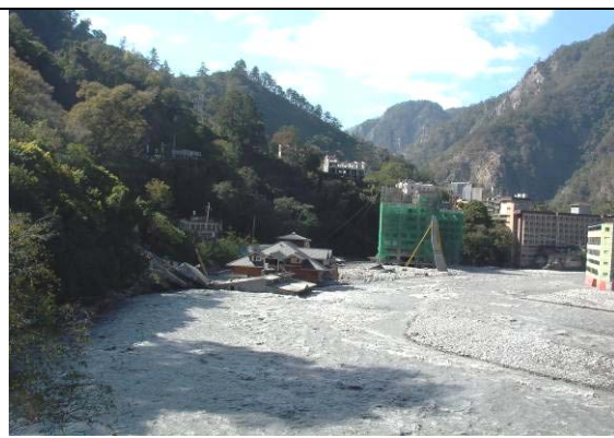
圖 54 谷關地區淤砂嚴重
