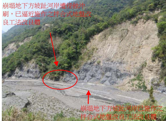
圖 10 合望「拌合式地盤改良工法」保全對象「崩塌地」
