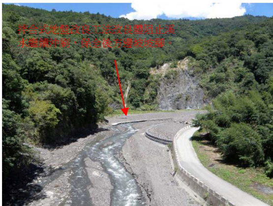
圖 11 紅香「拌合式地盤改良工法」保全對象「崩塌地」
