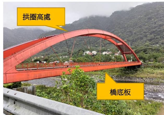
圖 1 松鶴橋，鋼結構橋梁示意圖
