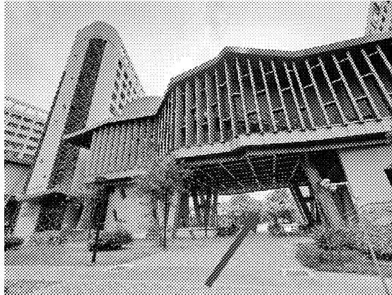
(2) 進入空橋下方
