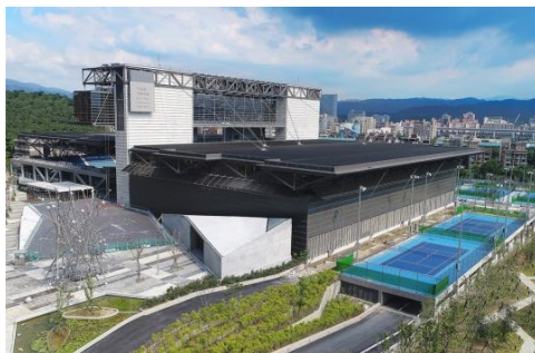
臺北市網球中心新建工程
