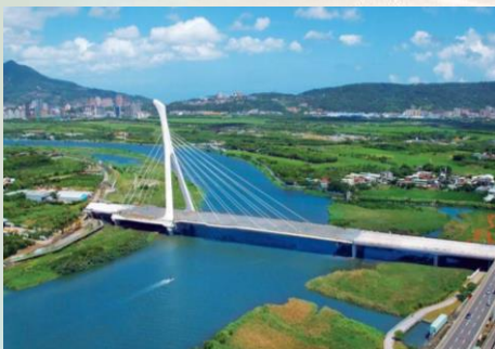
社子大橋新建工程第一期第一標
