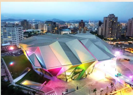
北部流行音樂中心興建工程 (北基地)
