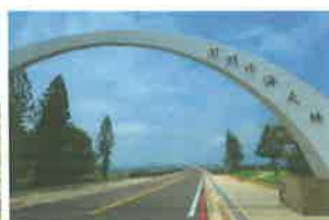
澎湖跨海大橋
