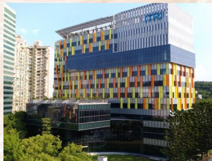
工研院光復院區 研發大樓新建工程
