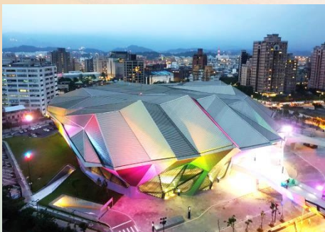
北部流行音樂中心興建工程 (北基地)
