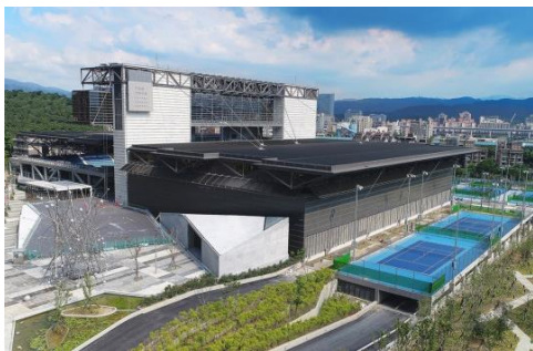
臺北市網球中心新建工程
