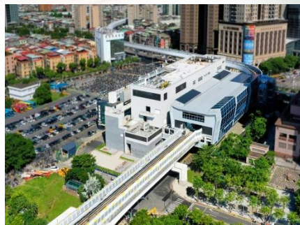
環狀線CF660A區段標工程-捷運環狀線板橋站
