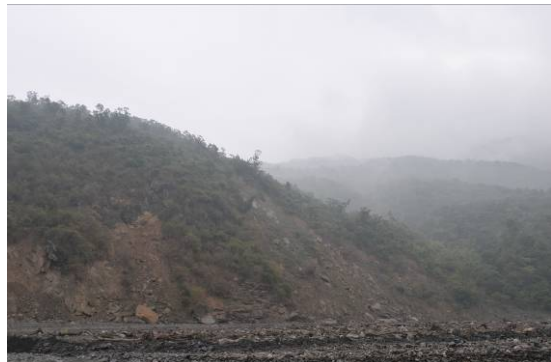
圖 10 河岸岩壁崩落情形(莫拉克風災後)
